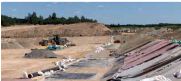
Aukštrakių sąvartyno Šiaulių regione įrengimo darbai.
