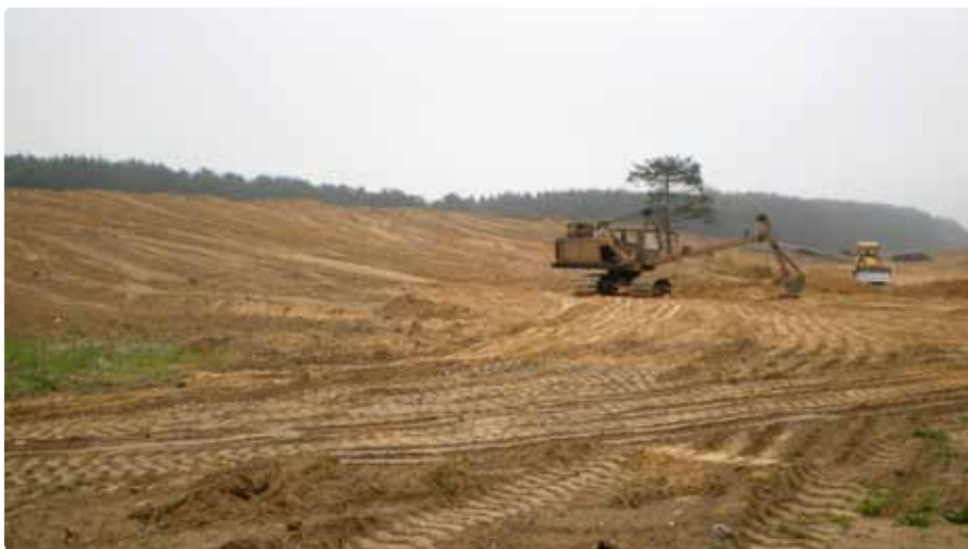
Jašiūnų sąvartyno Šalčininkų rajone uždarymo darbai: atliekų kaupio uždengimas gruntu.
