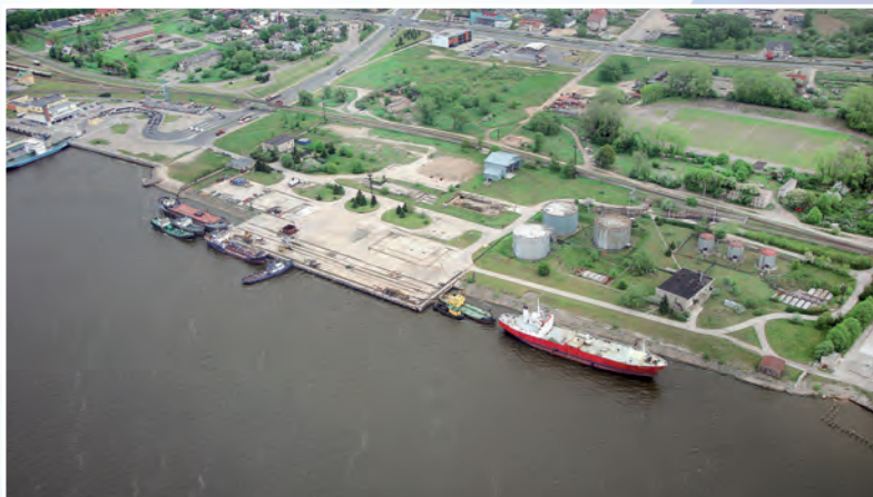
Keleivinių ir krovinių keltų terminalo infrastruktūros įrengimas Construction of infrastructure for the passenger and cargo ferries terminal
