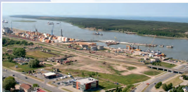
Keleivinių ir krovinių keltų terminalo infrastruktūros įrengimas Construction of infrastructure for the passenger and cargo ferries terminal
