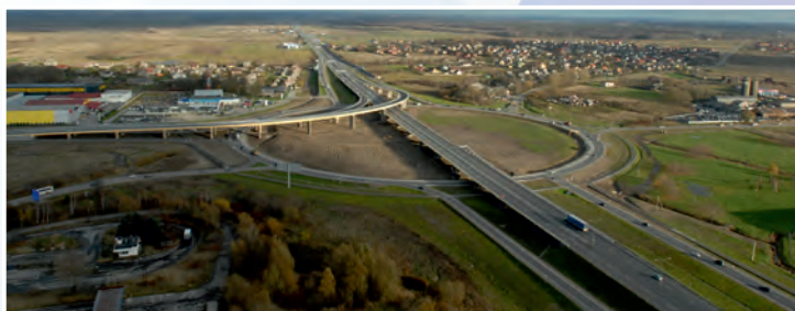
Jakų sankryžos rekonstrukcija The reconstruction of Jakai crossroad
