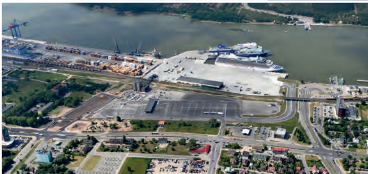
Keleivinių ir krovininių keltų terminalo infrastruktūros įrengimas Construction of infrastructure for the passenger and cargo ferries terminal
