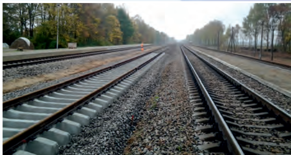
IXB Koridoriaus Vilniaus aplinkkelio Kyviškės-Valčiūnai antrojo kelio statyba Construction of second track of IXB passage of Vilnius bypass Kyviškės-Vaičiūnai
