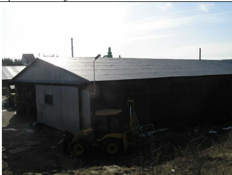
3 pav. Pastato 6F1g stogo bendras vaizdas
