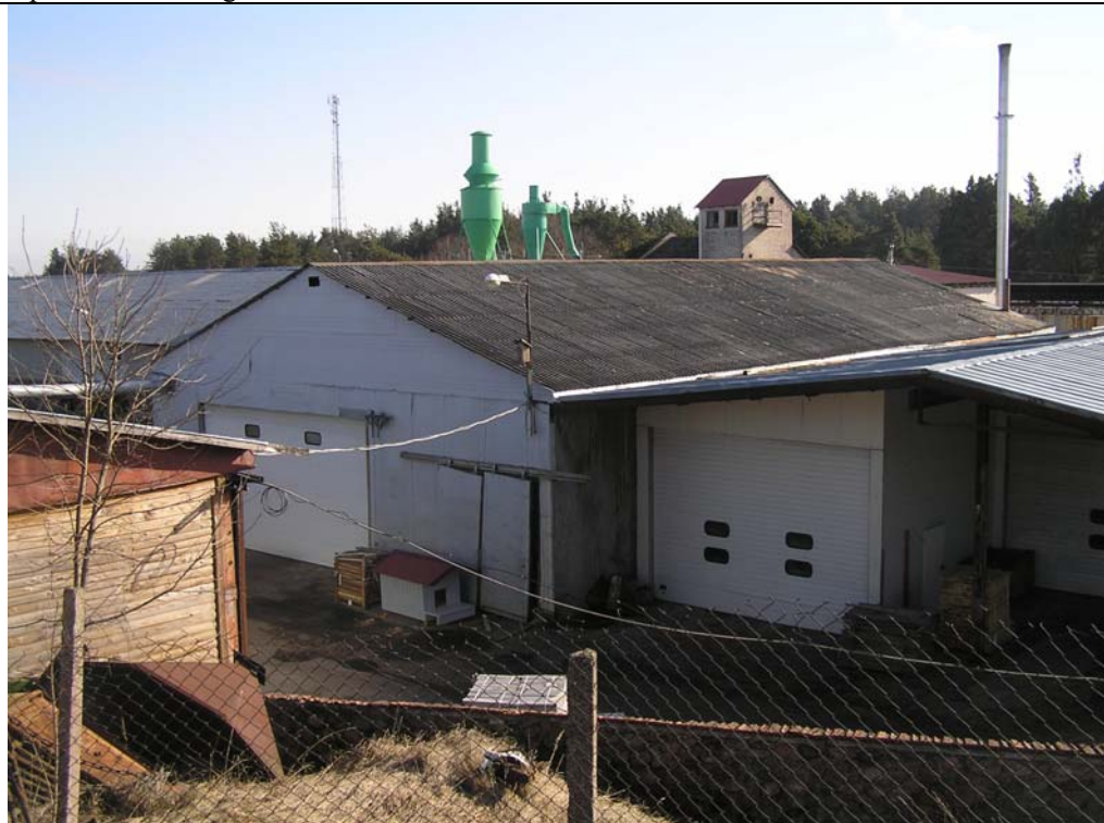
8 pav. Pastato 3F1g stogo bendras vaizdas
