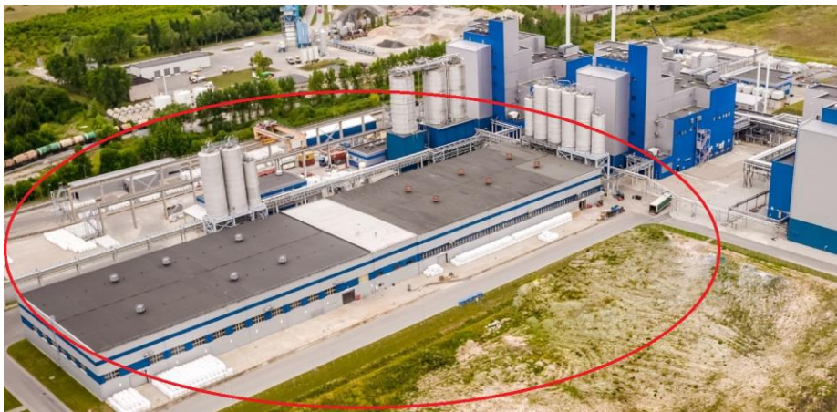
Gatavos produkcijas sandēlis obj. Nr. 02; maksimali apkrova 62 kg/m 2 , stogo plotas 9345 m 2 .
