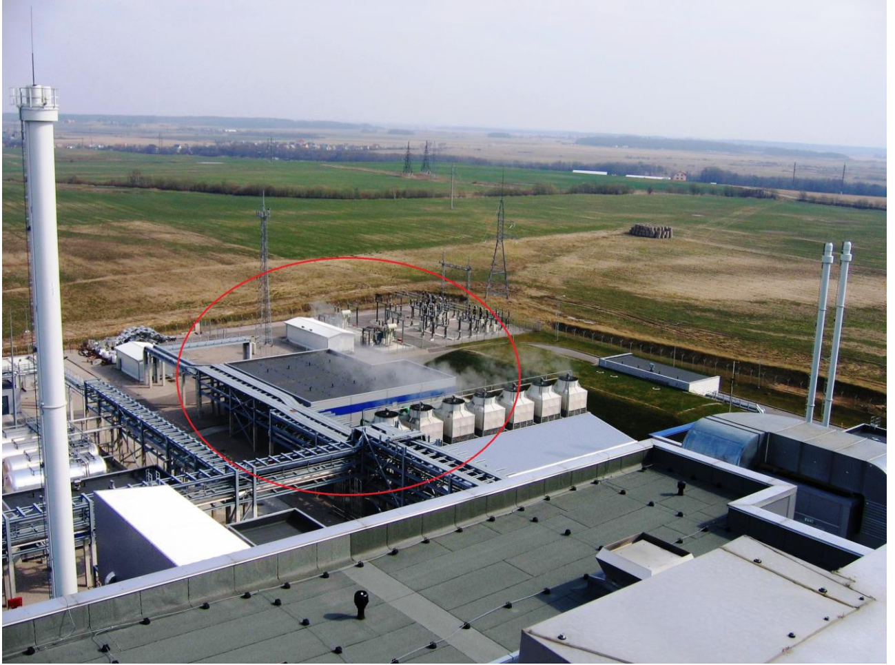
Vandens paruošimo korpusas obj. Nr. 13; maksimali apkrova -104 kg/m 2 , stogo plotas 515 m 2
