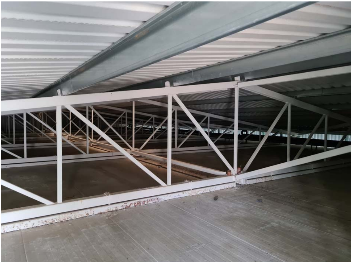
505 pav. Pastato Nr.5 stogo konstrukcijų fotofiksacija ir apmatavimai. Denginio konstrukcijų matmenys atitinka nurodytus archyvineame projekte.
