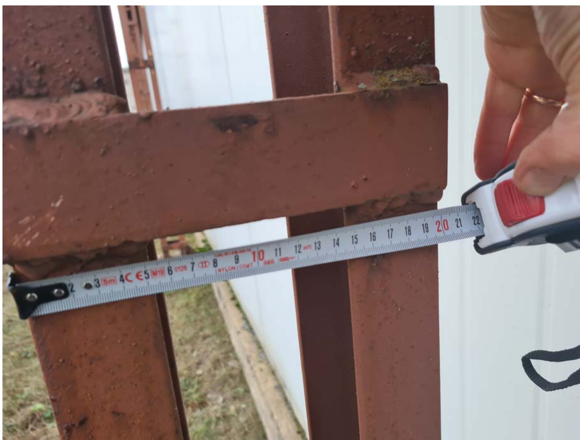
104 pav. Pastato Nr.1.1. konstrukcijų fotifiksacija. Kolona sudaryta iš dviejų lovių Nr.12
