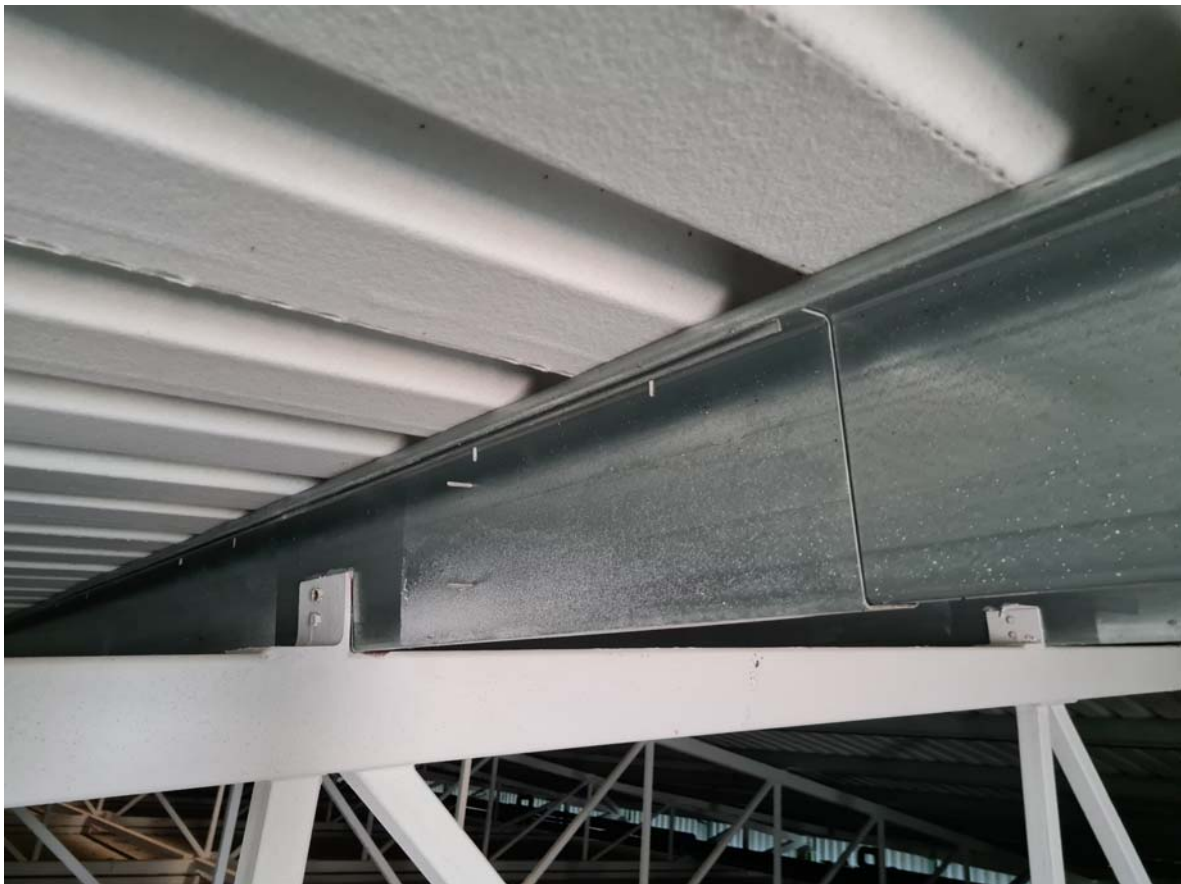
508 pav. Pastato Nr.5 stogo konstrukcijų fotofiksacija ir apmatavimai. Denginio konstrukcijų matmenys atitinka nurodytus archyvineame projekte.
