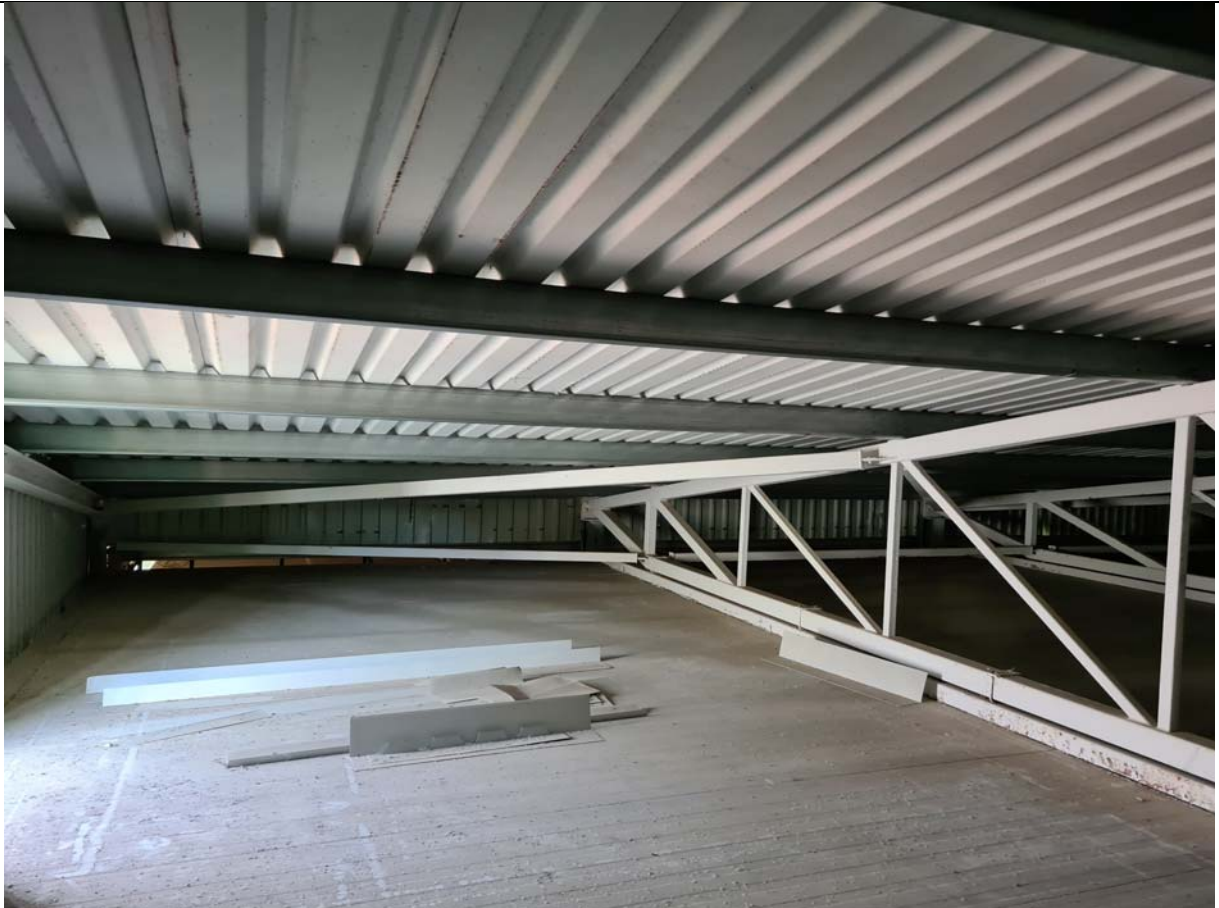
504 pav. Pastato Nr.5 stogo konstrukcijų fotofiksacija ir apmatavimai. Denginio konstrukcijų matmenys atitinka nurodytus archyvineame projekte.
