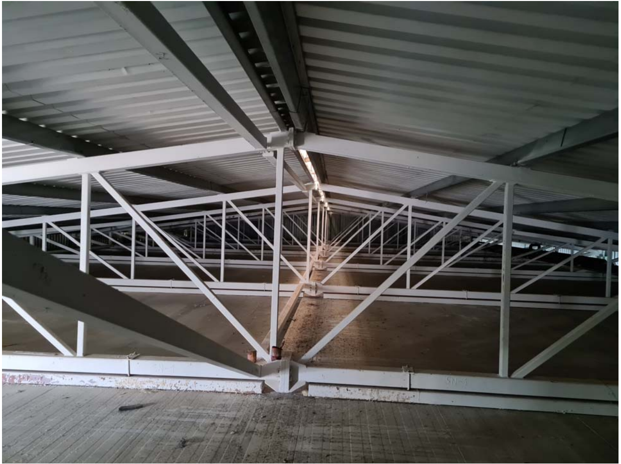
506 pav. Pastato Nr.5 stogo konstrukcijų fotografacija ir apmatavimai. Denginio konstrukcijų matmenys atitinka nurodytus archyvineame projekte.
