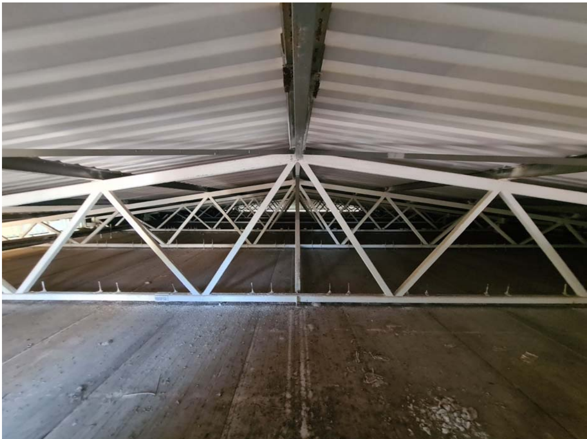
404 pav. Pastato Nr.4 stogo konstrukcijų fotofiksacija ir apmatavimai. Denginio konstrukcijų matmenys atitinka nurodytus archyvineame projekte.
