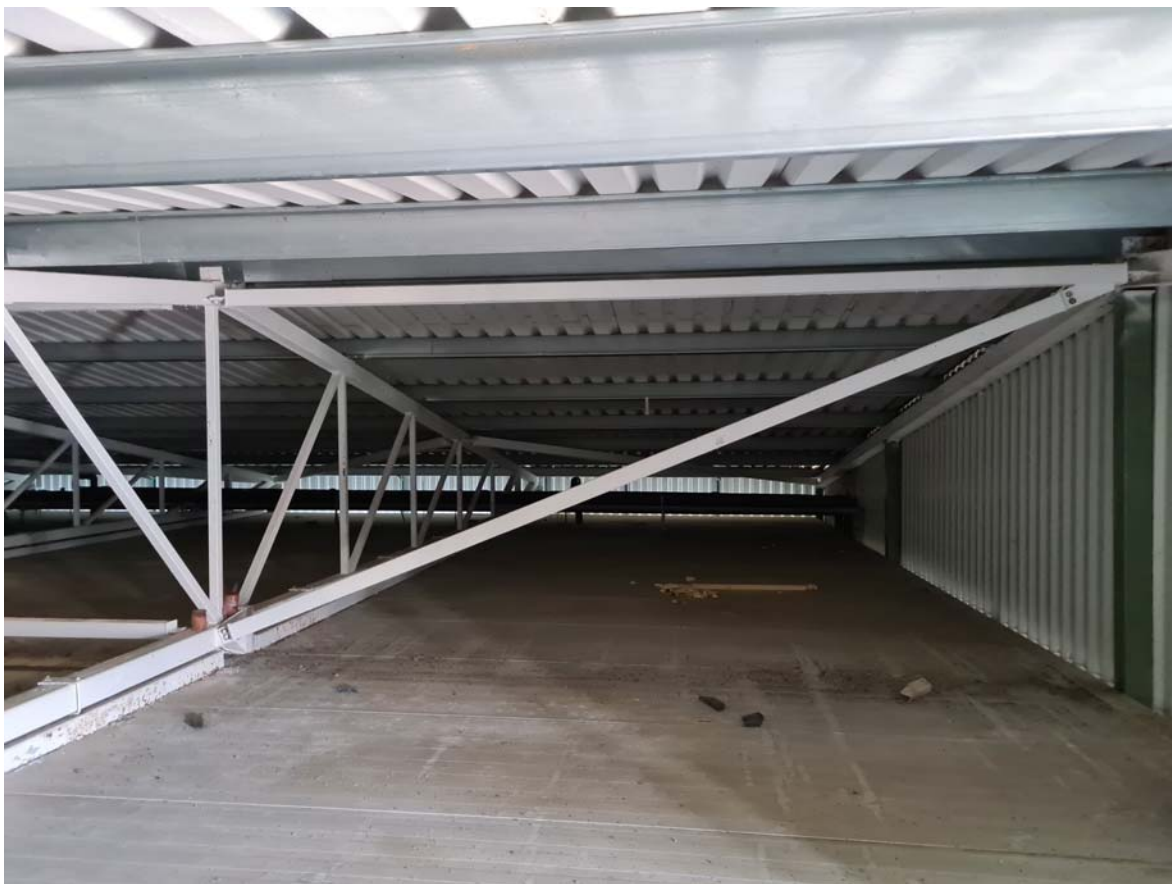
507 pav. Pastato Nr.5 stogo konstrukcijų fotografacija ir apmatavimai. Denginio konstrukcijų matmenys atitinka nurodytus archyvineame projekte.
