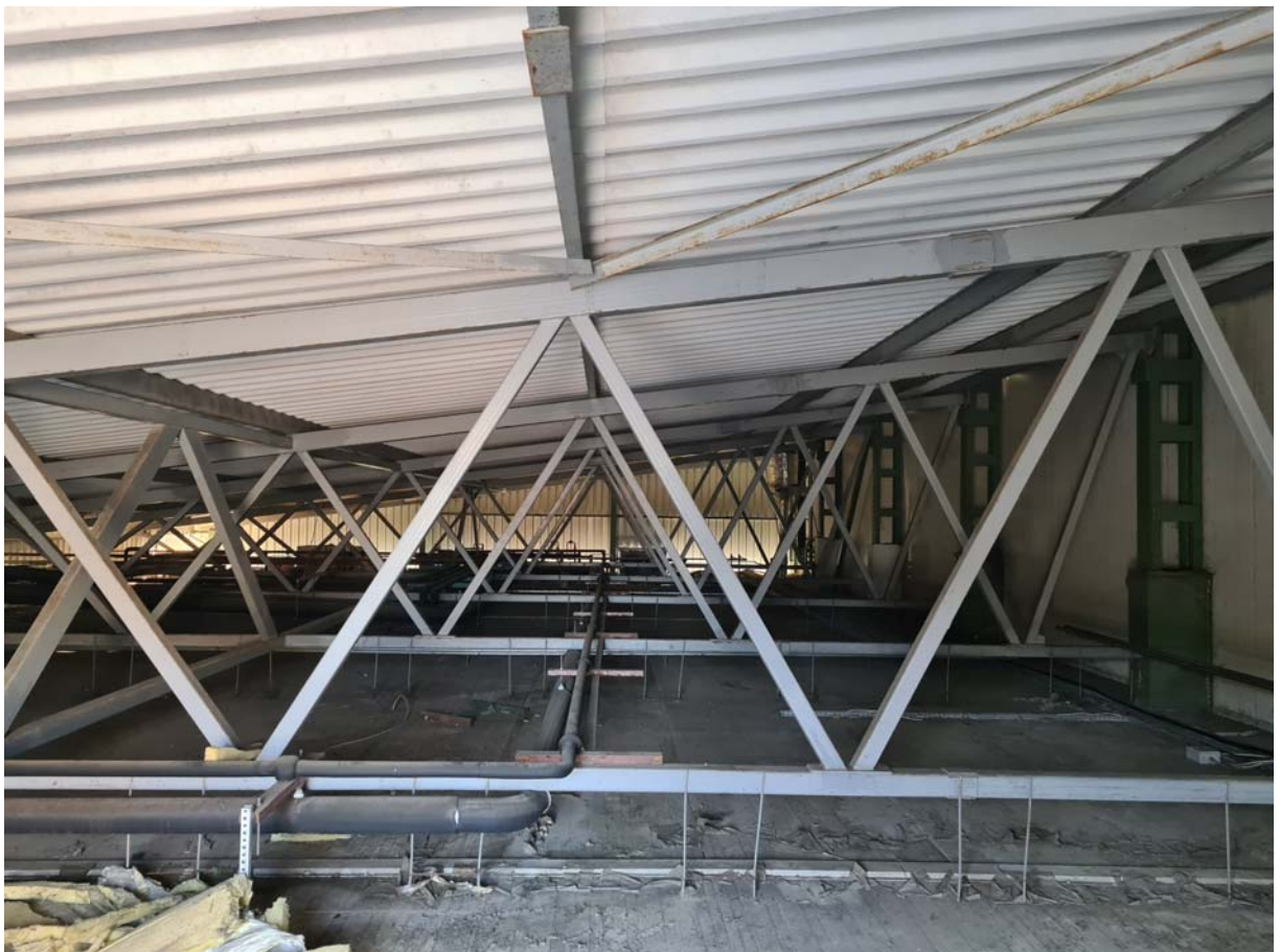
204 pav. Pastato Nr.1.2. stogo konstrukcijų fotofiksacija ir apmatavimai. Denginio konstrukcijų matmenys atitinka nurodytus archyvineame projekte.
