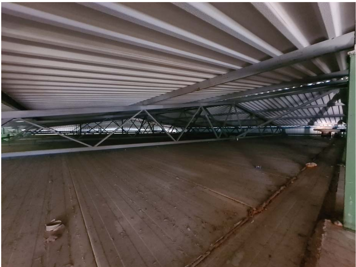
303 pav. Pastato Nr.1.3. stogo konstrukcijų fotofiksacija ir apmatavimai. Denginio konstrukcijų matmenys atitinka nurodytus archyvineame projekte.
