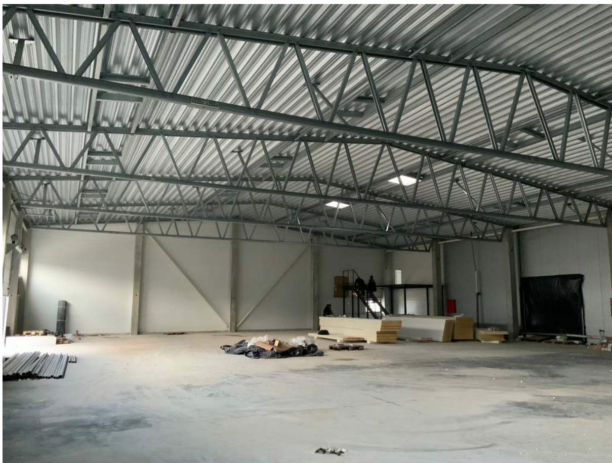
204 pav. Statinio 2P1/g priestato 1p1/b konstrukcijų fotografacija (statybos metu)
