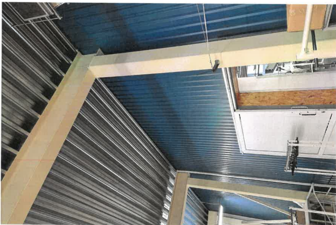
Pav. 6 Priestato 2F2p metalinių konstrukcijų, sijų ir laikančiojo pakloto vaizdas
