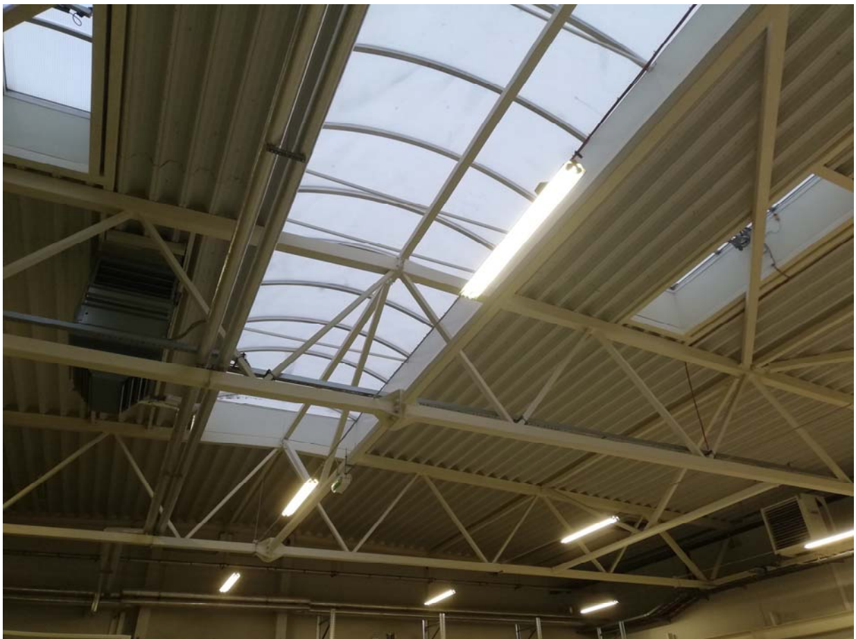
08 pav. Nagrinėjamo statinio stogo konstrukcijų fotofiksacija
