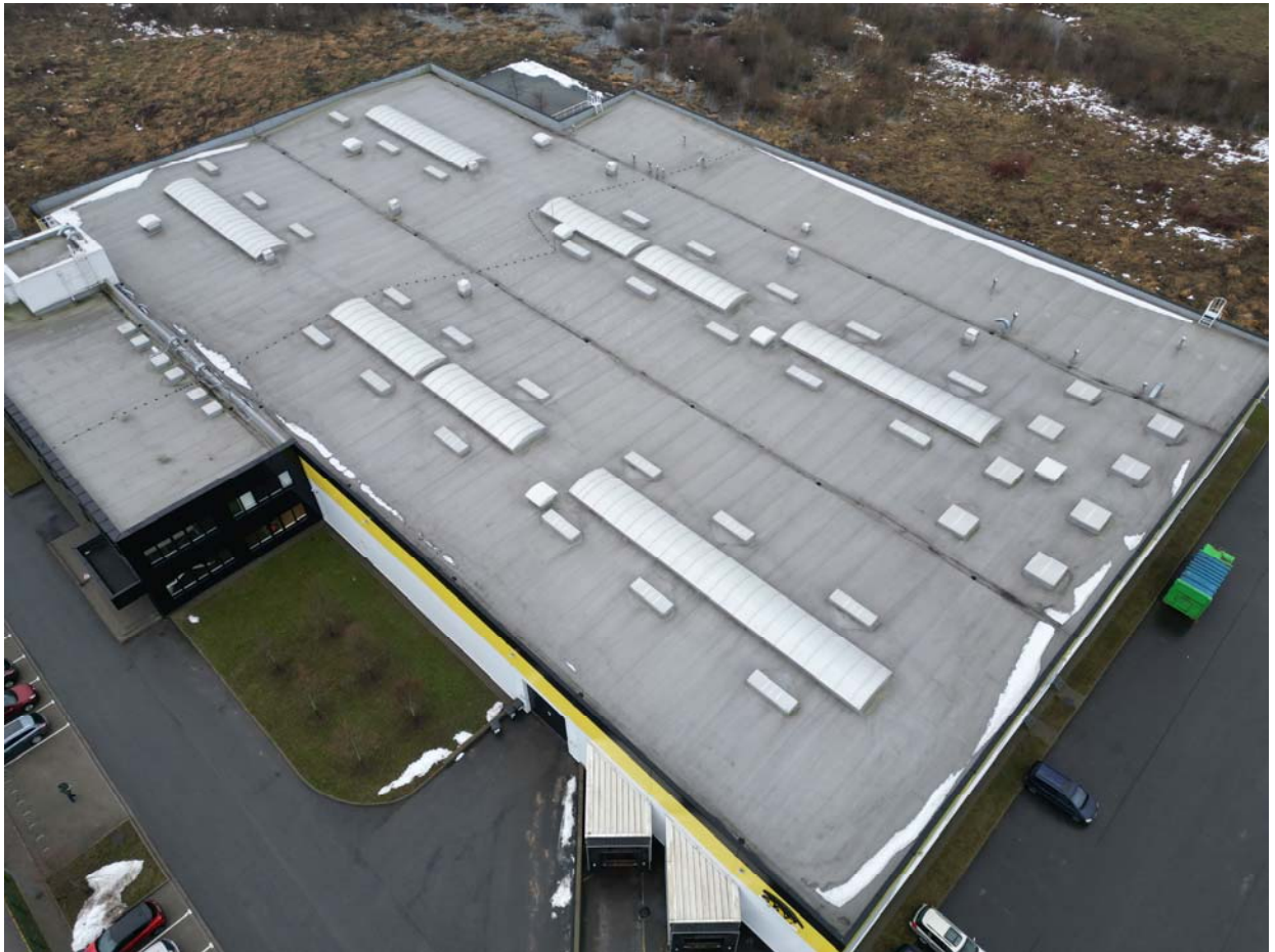
01 pav. Nagrinėjamo statinio stogo fotofiksacija (Archyvinė statytojo foto)
