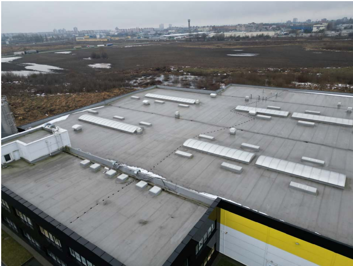
03 pav. Nagrinėjamo statinio stogo fotografacija (Archyvinė statytojo foto)
