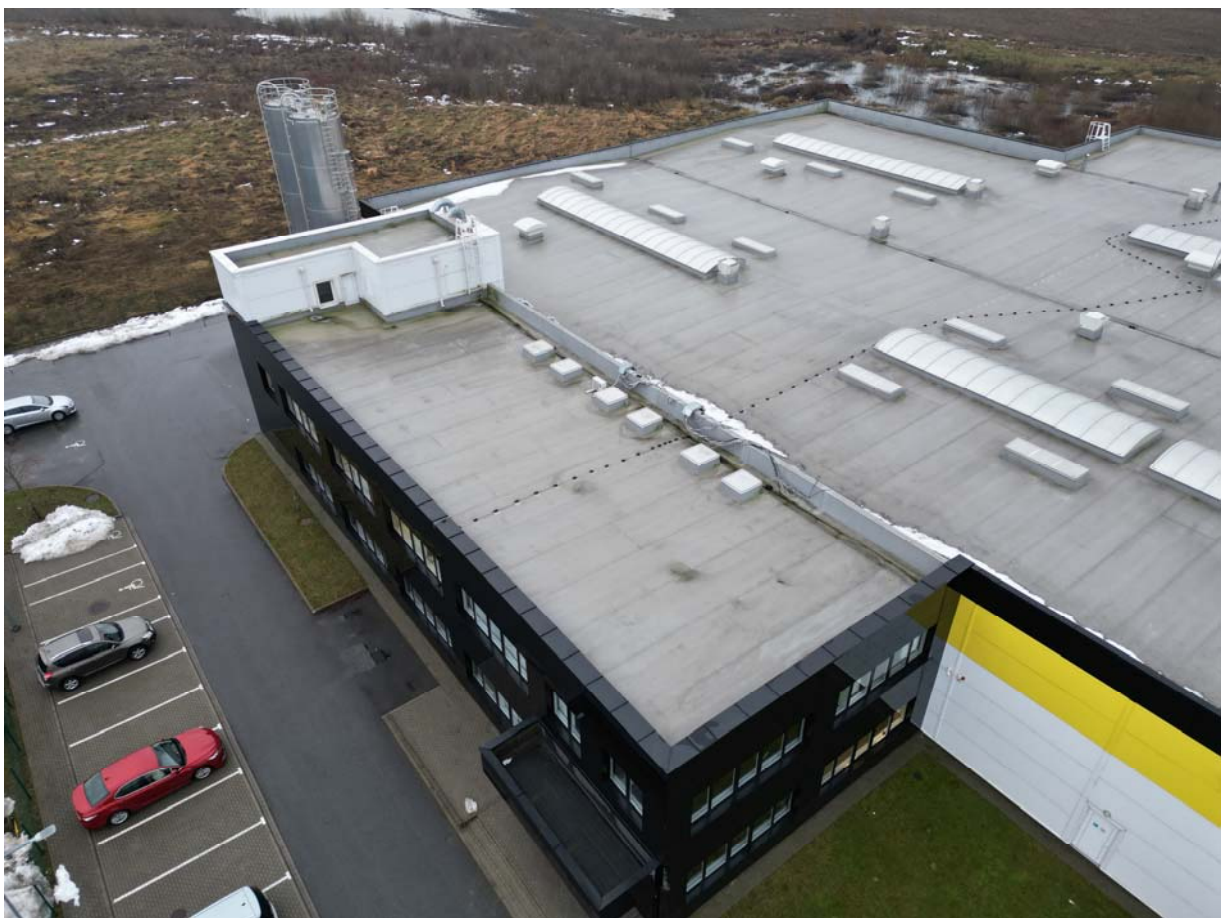
02 pav. Nagrinėjamo statinio stogo fotofiksacija (Archyvinė statytojo foto)
