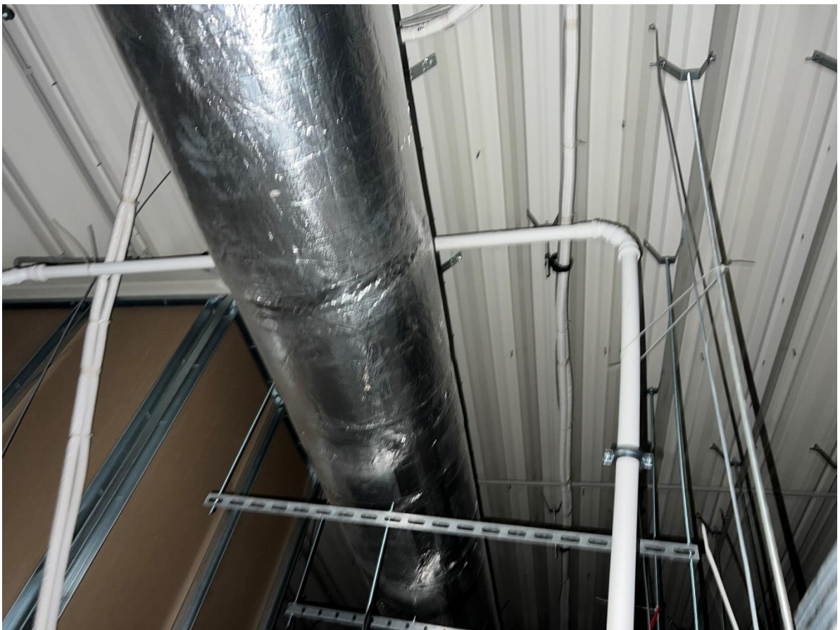
14 pav. Denginio konstrukcijos fotofiksacija (1)
