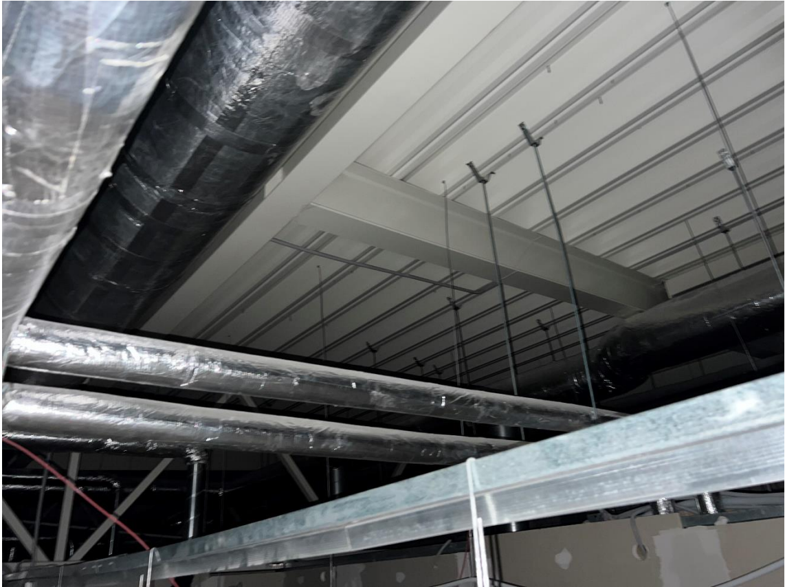
15 pav. Deginio konstrukcijos fotofiksacija (2)
