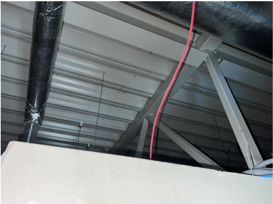
16 pav. Deginio konstrukcijos fotofiksacija (3)
