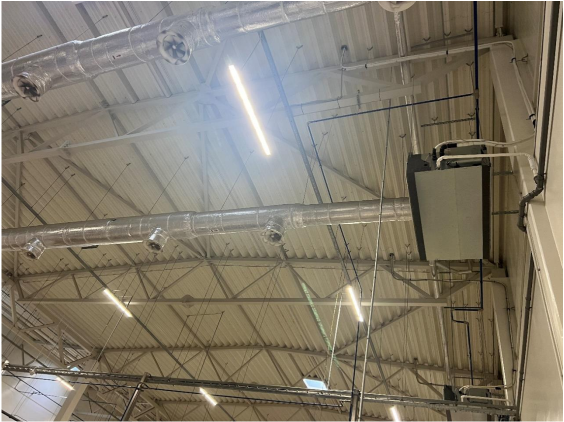
3 pav. Tiriamos pastato dalies vidaus patalpų ir esamų plieninių konstrukcijų fotografacija (2)
