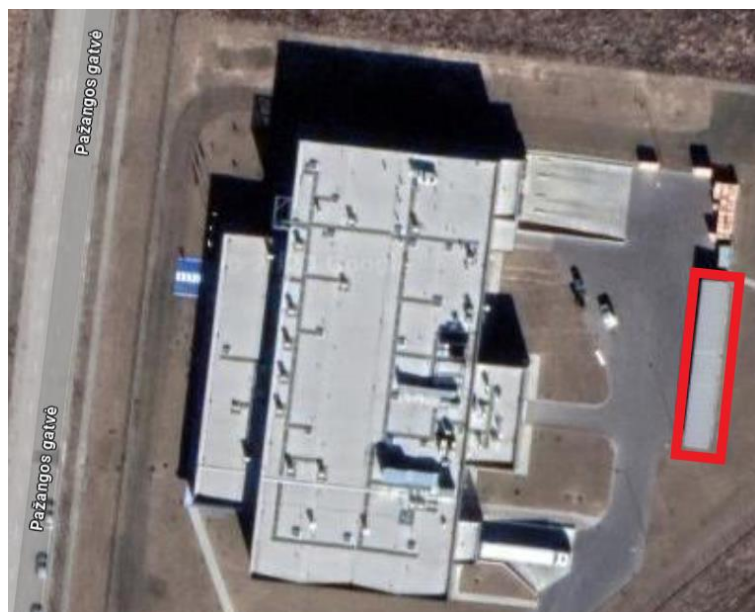
11 pav. Pastato denginys, ant kurio planuojamas fotovoltinės jėgainės montavimas
