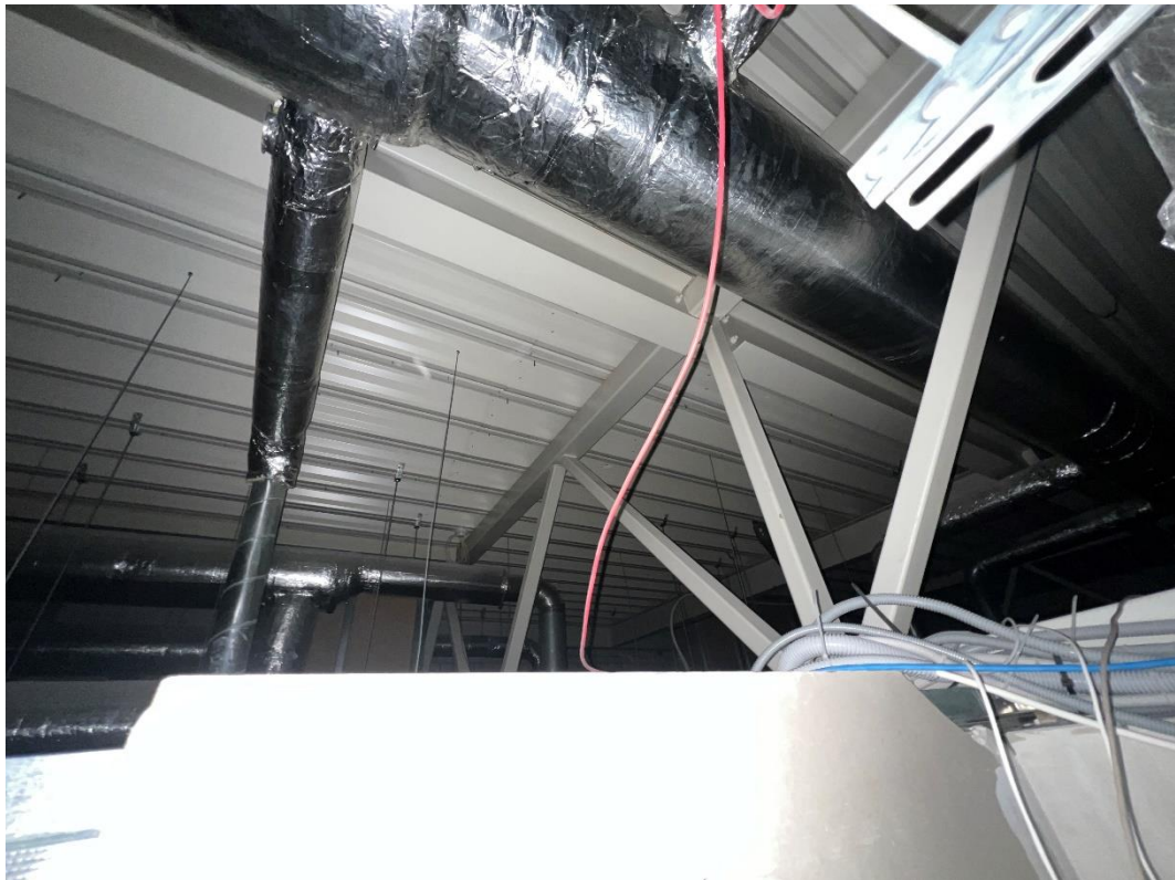
17 pav. Denginio konstrukcijos fotofiksacija (4)
