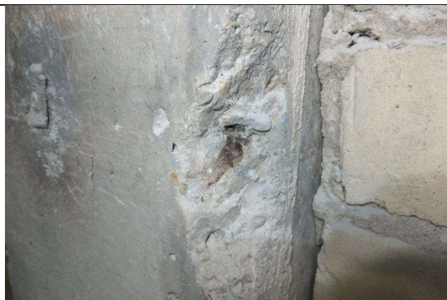
17 pav. Mechanškai pažeistas kolonos apsauginis betono sluoksnis. Korozijos paveikta armatūra.
