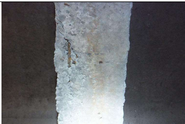
14 pav. Pažeistas g/b sijos apsauginis betono sluoksnis, kurį reikalinga atstatyti
