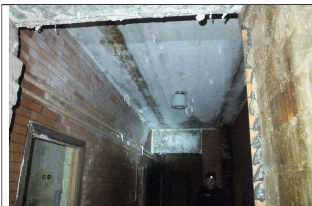
21 pav. Perdangos plokštė pirmame administracinio korpuso aukšte. Dėl nesandarios stogo dangos matomi vandens pratekėjimai. Reikalingas stogo dangos atnaujinimas.
