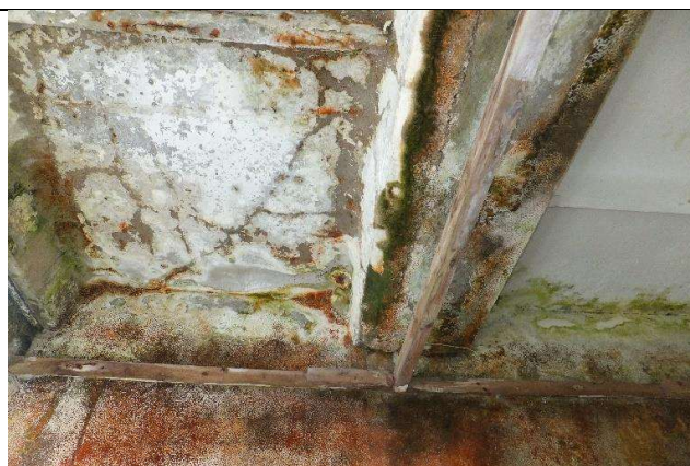
26 pav. Įtrūkimai plokštėje, betono ir armatūros korozija, biopažaidos.
