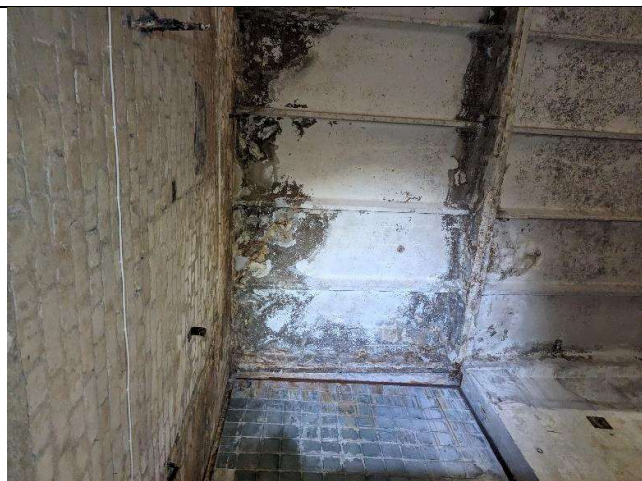
30 pav. Nutrupėjęs briaunuotų plokščių briaunų apsauginis betono sluoksnis ties atrama, korozijos pažeista briaunos armatūra.
