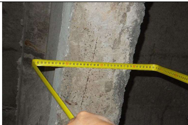
13 pav. Išmatuotas dvišlaitės g/b sijos apatinės lentynos plotis.
