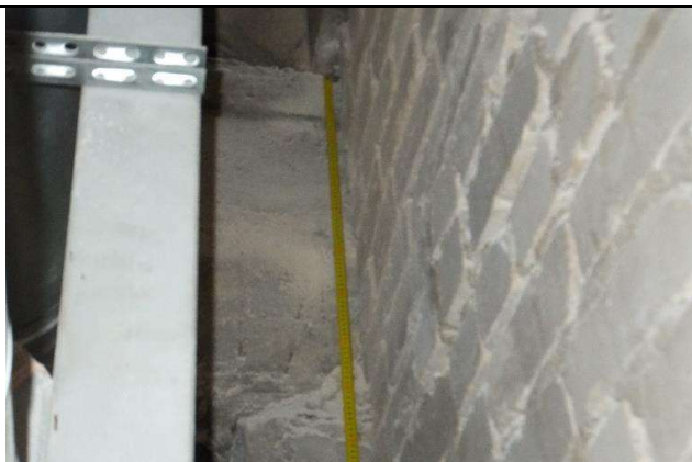
12 pav. Išmatuotas dvišlaitės g/b sijos aukštis.
