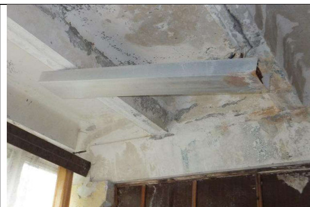
23 pav. Drėgmės poveikio požymiai ant antro aukšto lubų. Reikalingas stogo dangos atnaujinimas.
