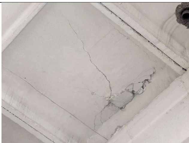
31 pav. Sutrūkinėjusi plokštės lentyna gamybinėje dalyje.
