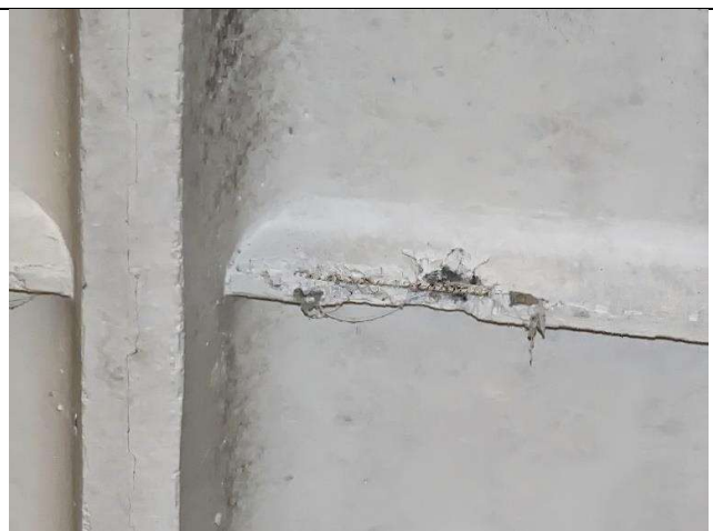
32 pav. Nutrupėjęs briaunuotų plokščių briaunų apsauginis betono sluoksnis gamybinėje dalyje.
