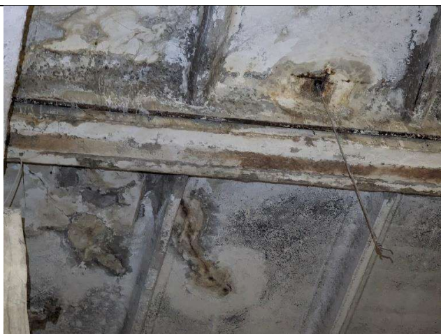
33 pav. Išilginiai įtrūkimai plokštės briaunoje gamybinėje dalyje.
