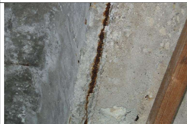
25 pav. Matoma korozijos paveikta plokštės armatūra.
