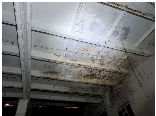
34 pav. Matomos drėgmės pažaidos ant perdangų ir ienos gamybinėje dalyje.
