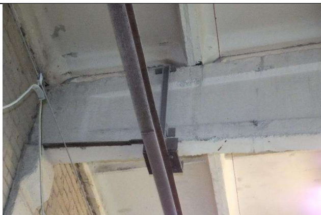
18 pav. Dvišlaičių sijų atrėmimo ir tiltinio krano pakabinimo mazgai.
