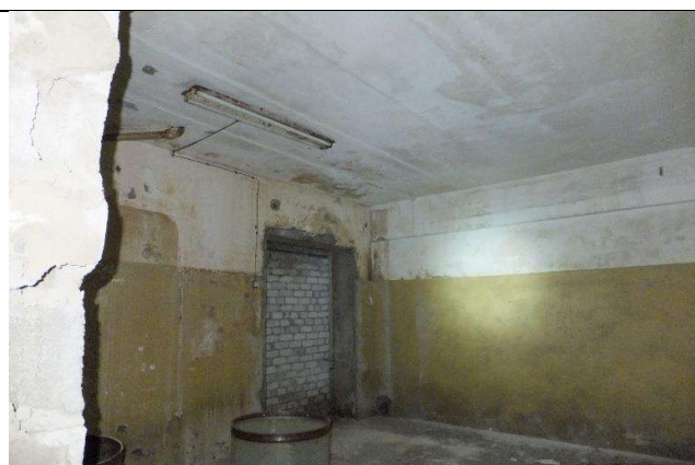
22 pav. Perdangos plokštė pirmame administracinio korpuso aukšte. Dėl nesandarios stogo dangos matomi vandens pratekėjimai. Reikalingas stogo dangos atnaujinimas.
