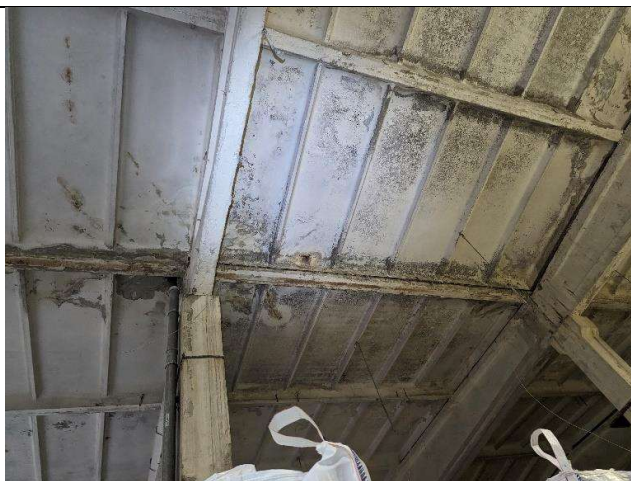
29 pav. Dėl stogo dangos nesandarumo matomos vandens pratekėjimo žymės.
