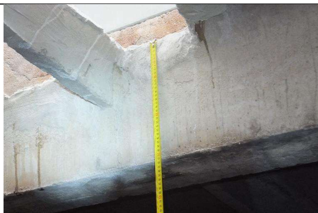
28 pav. Išmatuotas plokštės aukštis gamybinėje pastato dalyje.
