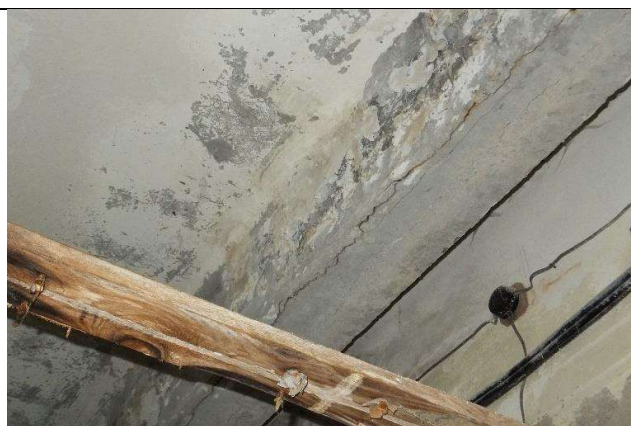
24 pav. Sutrūkinėjusi plokštės briauna antrame aukšte.
