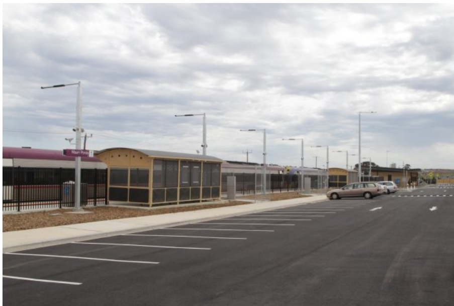
1.10 pav. Trumpalaikio stovėjimo įlaipinimo–išlaipinimo aikštelės ( http://www.railgeelong.com/ )
